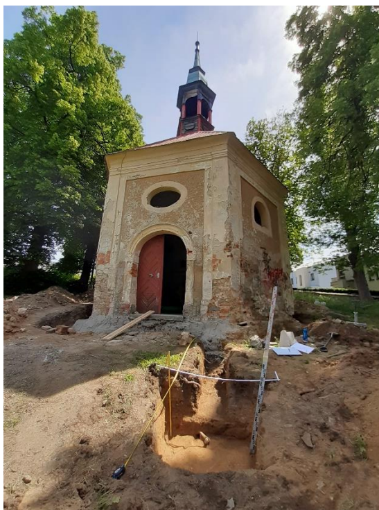
Domažlice – kaple sv. Jana Nepomuckého – celkový pohled na staveniště
