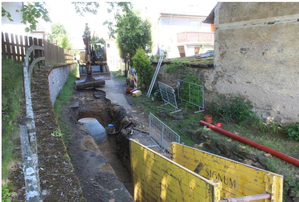
Pasečnice, výkop pro kanalizaci a vodovod v blízkosti zaniklého středověkého probošství (u čp.42)
