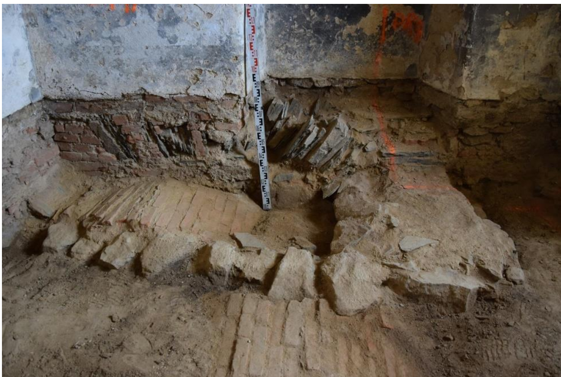
Semněvice – fara, odkryté zdivo se záklenkem předcházející barokní faře - JZ kout budovy
