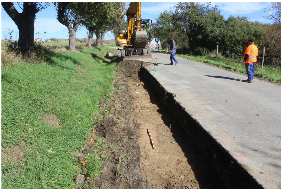
Mutěnin, dokumentovaný pravěký objekt při rekonstrukci komunikace
