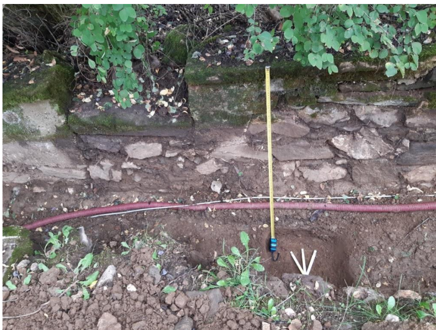
Šitboř, pohled od severu na ohradní zeď farské zahrady v místě mezi parcelními čísly 38 a 17 tvořící jižní profil výkopu pro el.kabel
