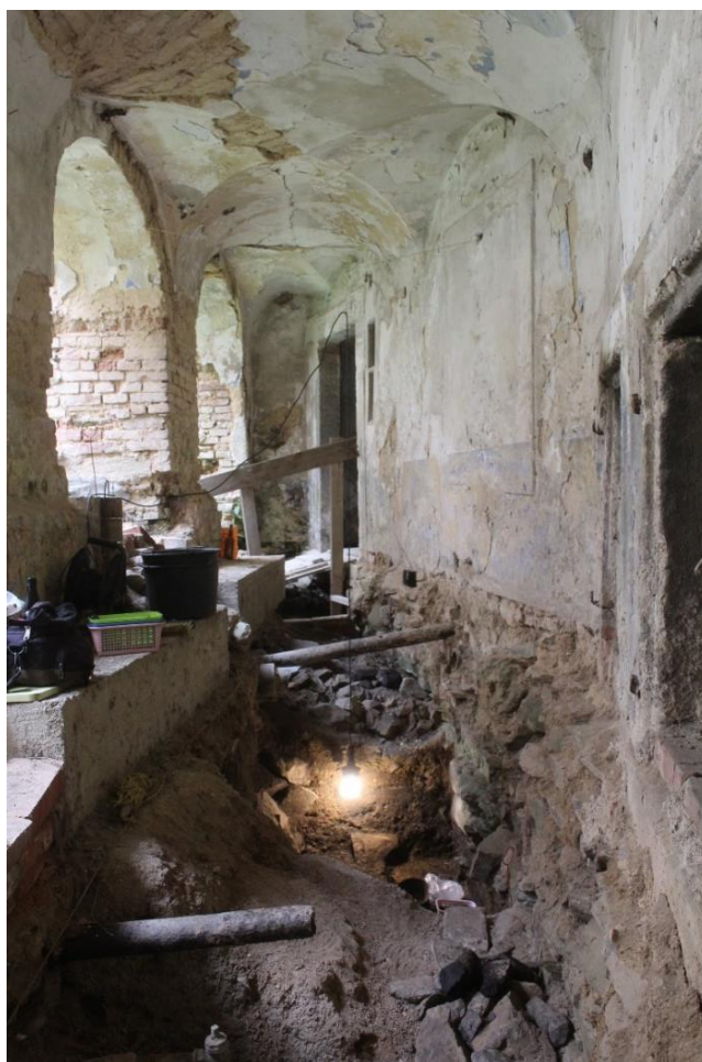
Poběžovice – zjišťovací sonda ve východní arkádě nádvoří, pohled od jihu
