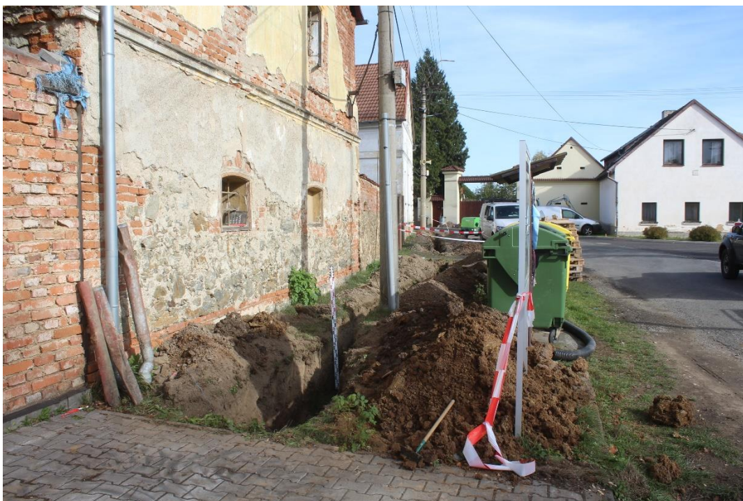
Vránov – výkop pro kNN před průčelím čp. 17, pohled od západu
