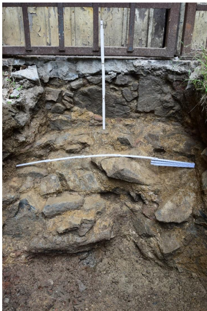
Kanice: odkrytý masivní předzáklad východní obvodové zdi zámku
