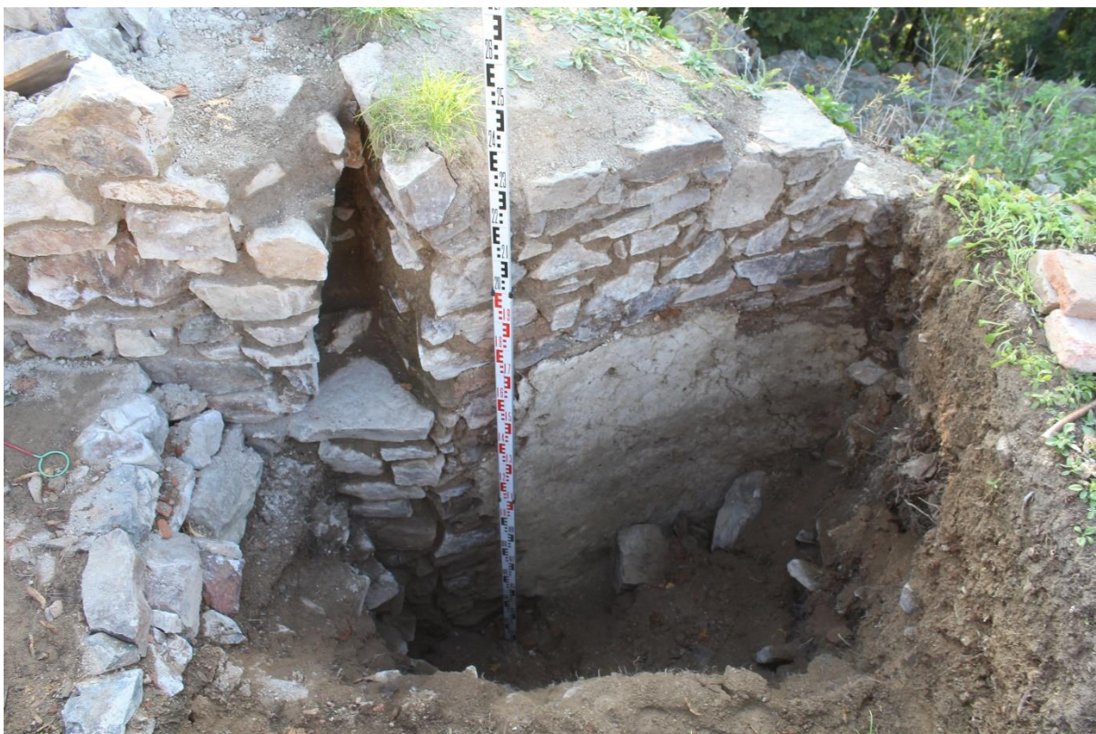
Rýzmbek – hrad, sonda odhalující styk zdiva paláce (vlevo) a předpokládaného bergfritu (vpravo)
